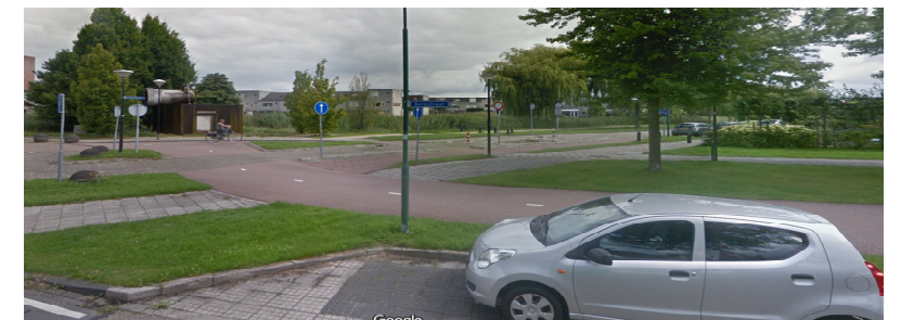
Aansluiting fietspad op de Bergstraat langs trafo/gemaalhuis
