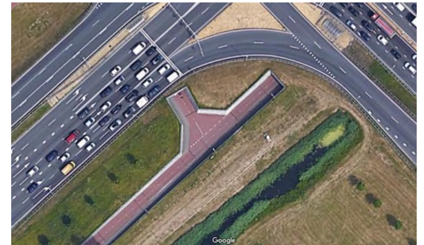
Foto van fietsonderdoorgang nabij Gelredome (Nijmeegseweg, Arnhem) en aansluitingen op overige fietsroutes richting het stadion. Er is extra (zicht)ruimte gecreëerd bij de aansluiting van de fietspaden
